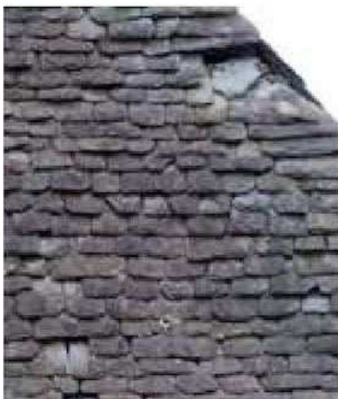
Ardoises épaisses posées au clou. Oloron Sainte-Marie.
