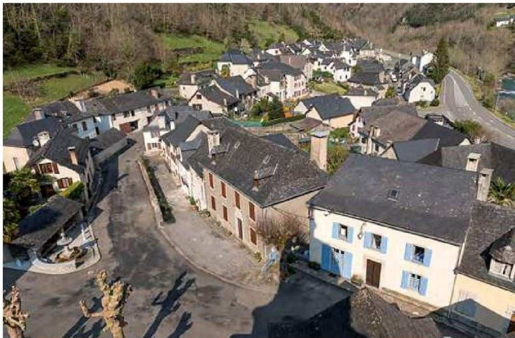
Vue des îlots bâtis. Sarrance.
