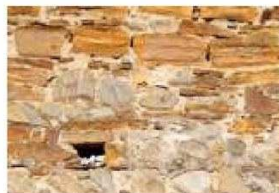
Appareil de grès, galets et moellons calcaires. Buziet.
