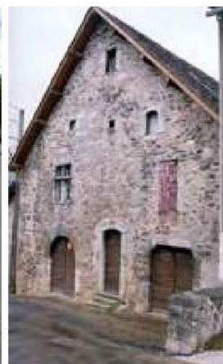
Parquille* de seuil, élément de clôture. Léas-Athas.
