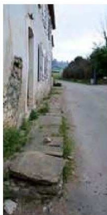
Dalles de pierres marquant le seuil. Estialescq.
