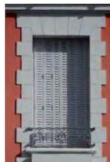
Volets repliables métalliques à persiennes.
