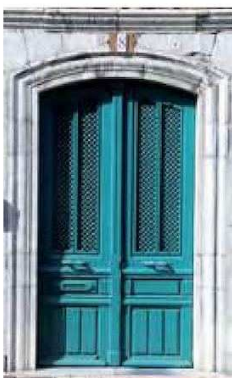
Porte avec sa ferronnerie. Oloron Sainte-Marie.
