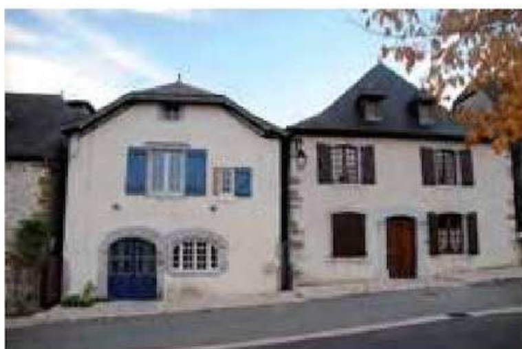
Maisons avec pignon sur rue à Rébénacq.
