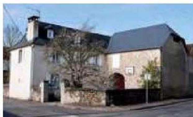
Maison et grange formant une cour. Verdets.
