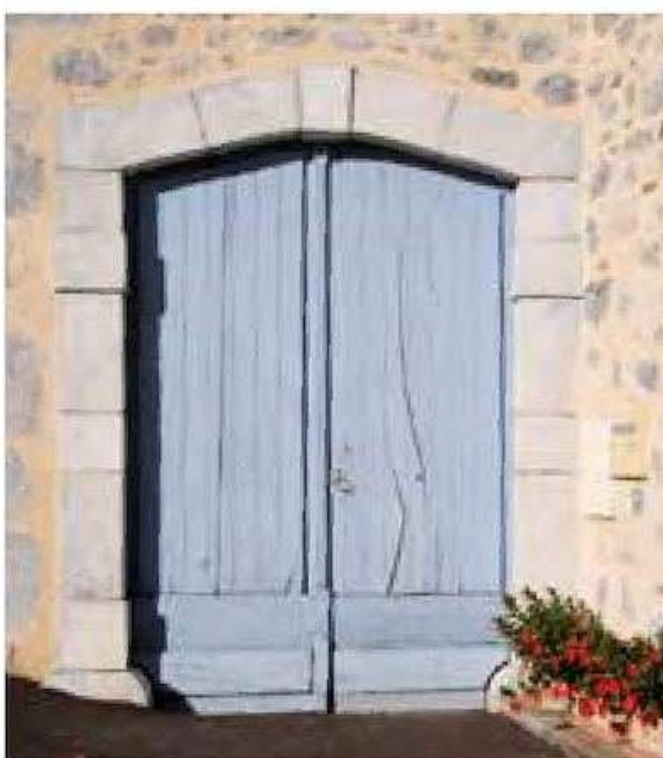
Porte à planches et contre-planches. Bescat.
