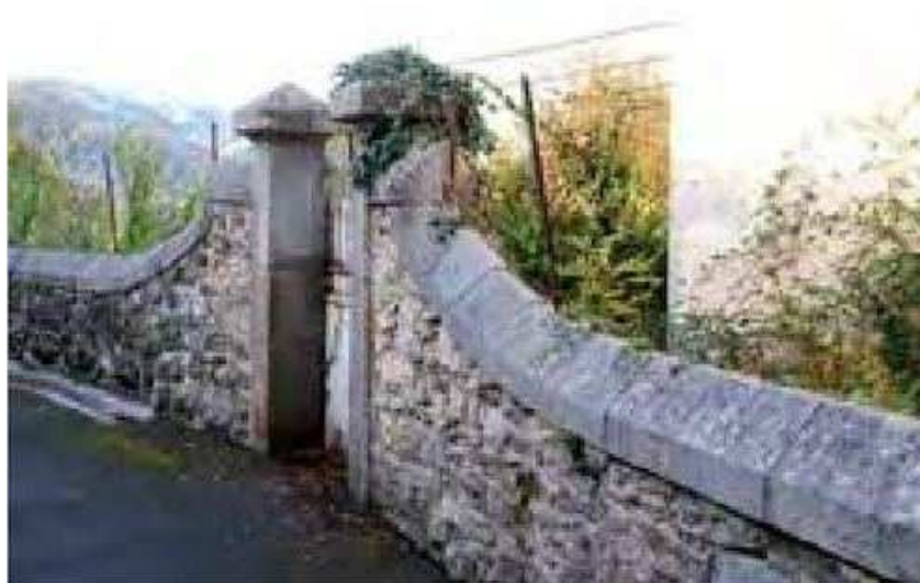
Muret à Sévignacq-Meyrac.
