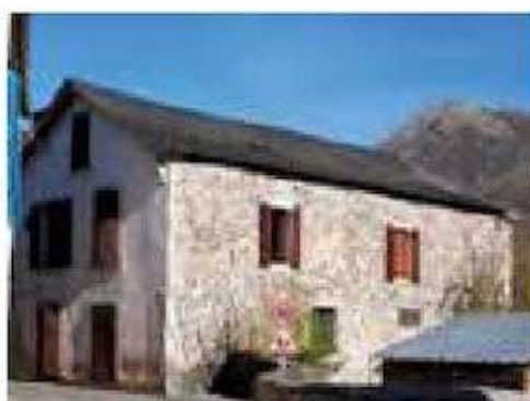
Toiture simple à deux pentes. Bielle.
