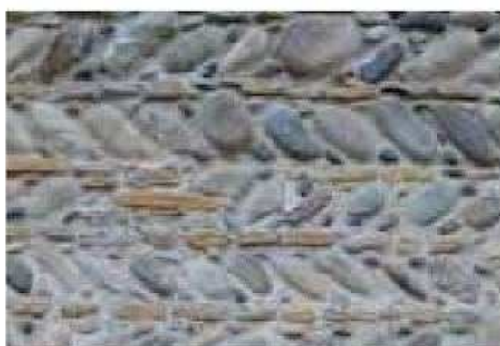
Appareil de galets en fougère sur assises de tuileaux. Précilhon.
